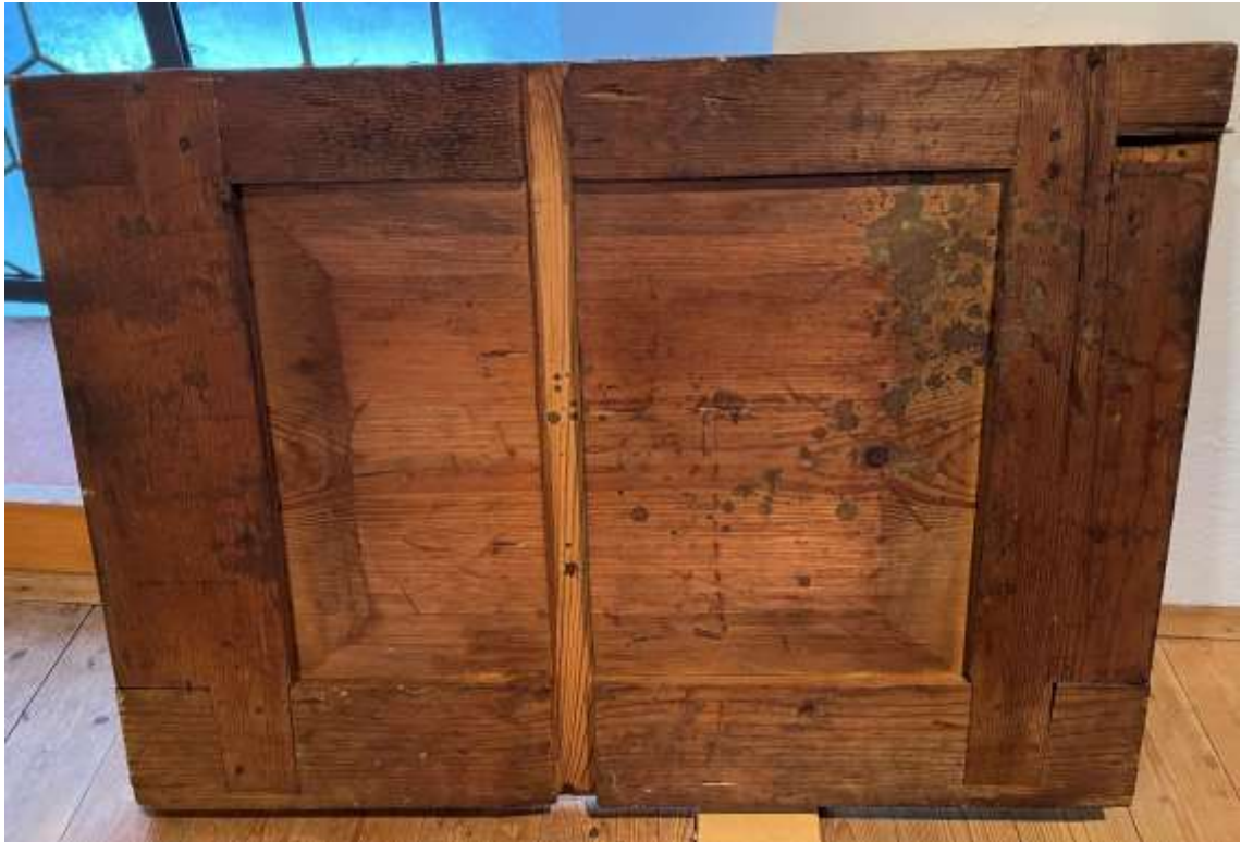
Abbildung 60 In der Mitte aufgetrennte Gehäuse-Füllungen
