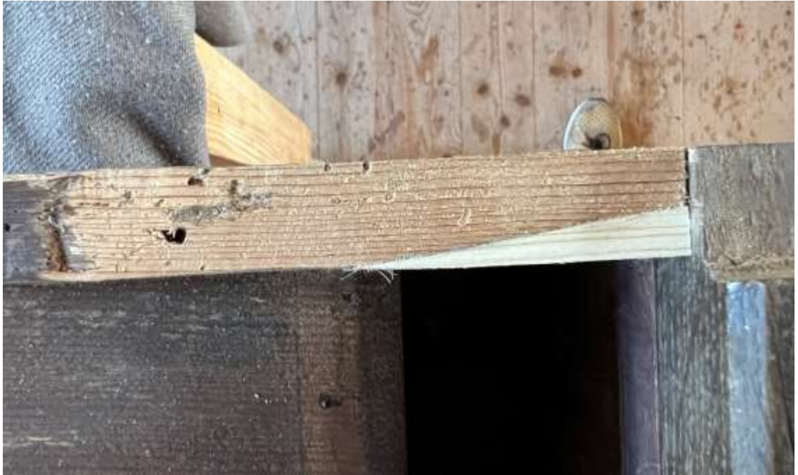
Abbildung 32 Reparatur der Holzpfeifen w.d.R.
