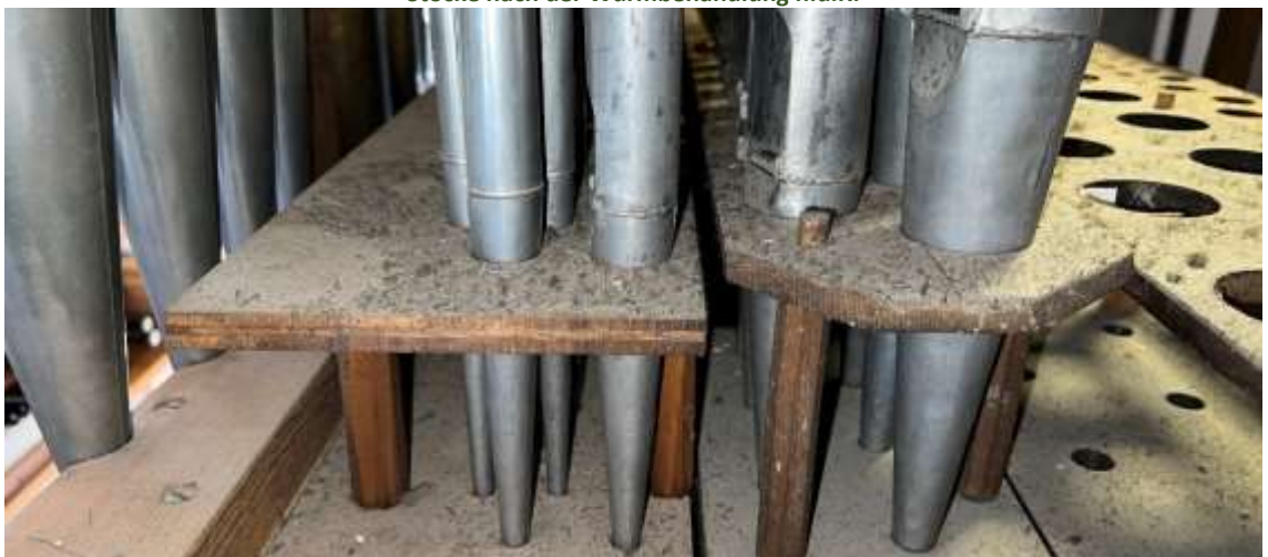
Abbildung 39 1982 erneuerte (links) und originale Rasterbretter (rechts) v.d.R.
