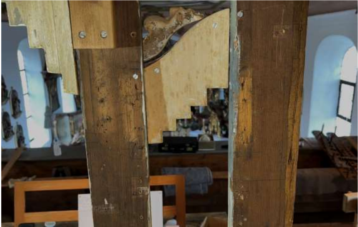
Abbildung 62 Erkennbare Rückstände ehemaliger Raster und Schleierwerke
