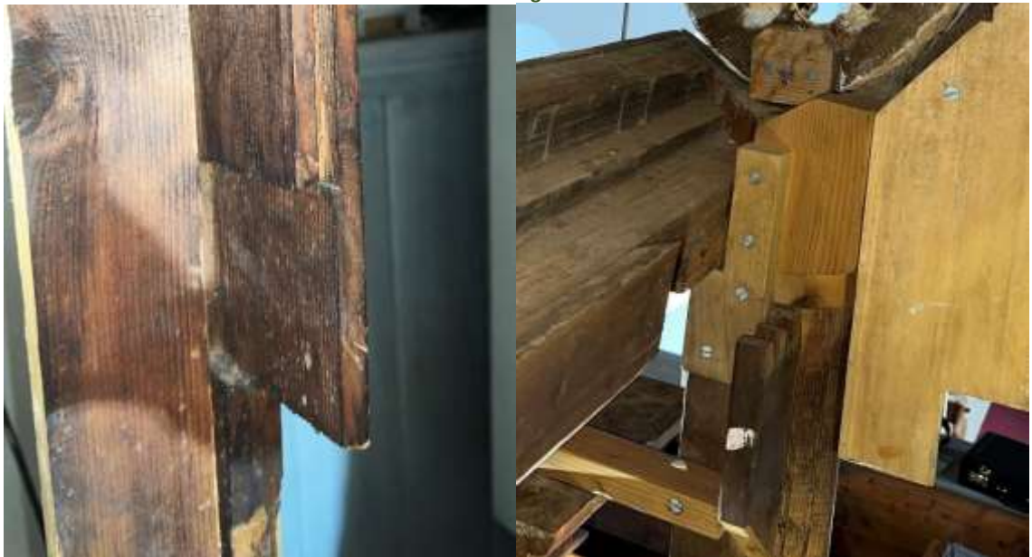
Abbildung 63 Zeichen fehlender Gehäuseverbindungen
