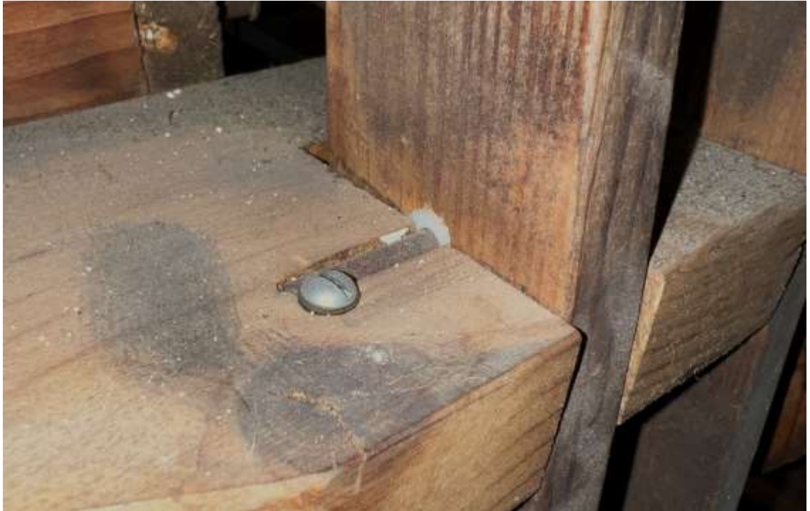
Abbildung 48 Achslager der Registerschwerter
